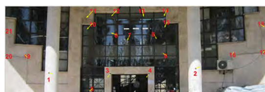
شکل ۱۴- بردار خطاهای محاسبه شده مولفه‌های X-Y برای نقاط چک انتخاب شده بر روی نما با ضریب اغراق ۱۰۰۰ برابر
